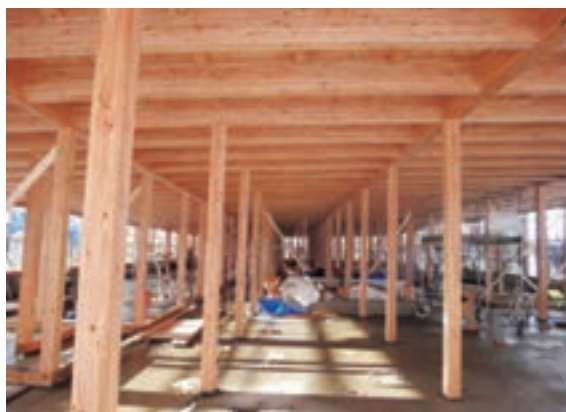
建て方状況：梁・柱材（町内産カラマツ構造用集成材）
