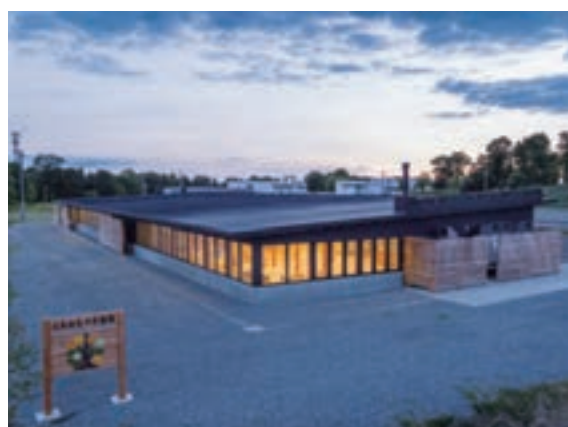
夕景俯瞰：室内での活動がよくわかる大きな開口部 ※
