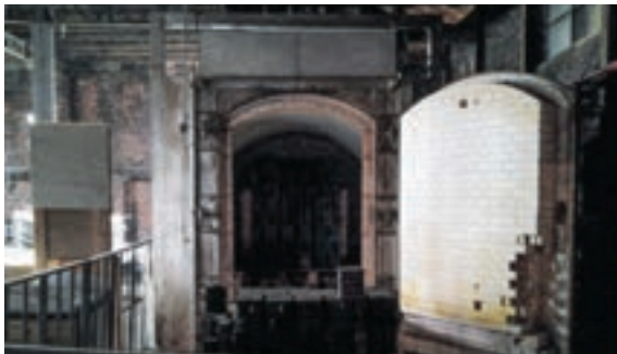
鎮座する焼成窯（修復前）
