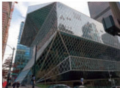
写真7 シアトル中央図書館
