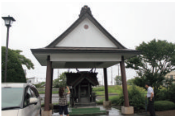
切妻屋根に覆われている標津の太子堂
