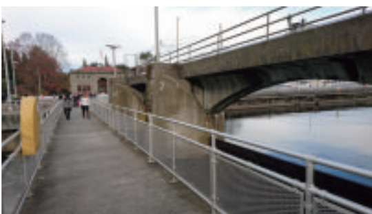
写真4 チッテンデン水門
