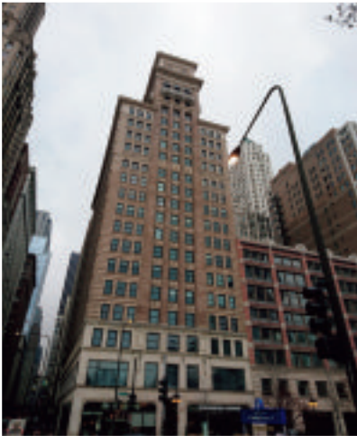
写真14 近接するビル群
