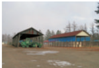
写真5 構内第4(左)・第5(右)牧草収納舎
