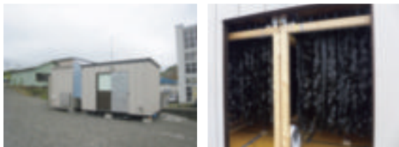
写真6 釧路町昆布森地区に移設した実証プラント
