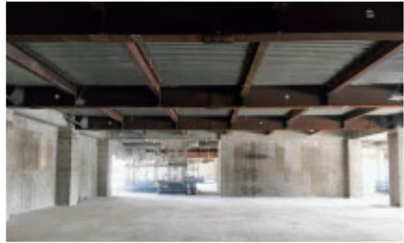
建設中の様子。RC柱とS梁の複合構造
