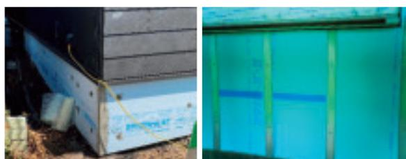
写真8 外断熱改修の断熱材
