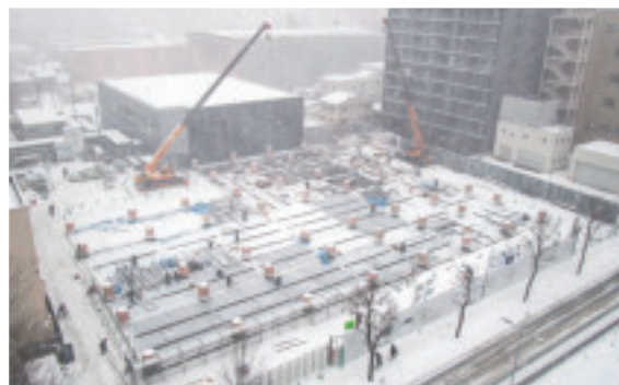
(a)降雪時の躯体工事
