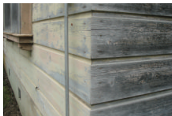
写真2 下見板張りの外壁
