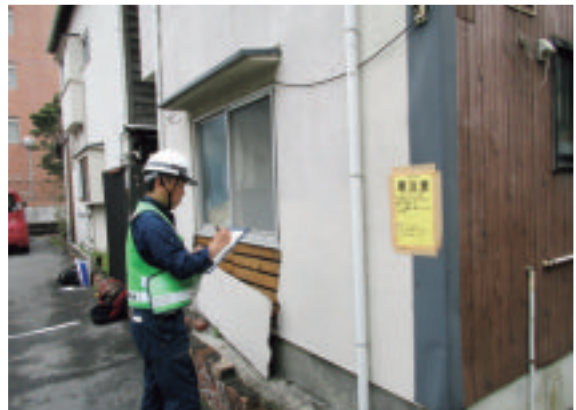
被災地での応急危険度判定作業
