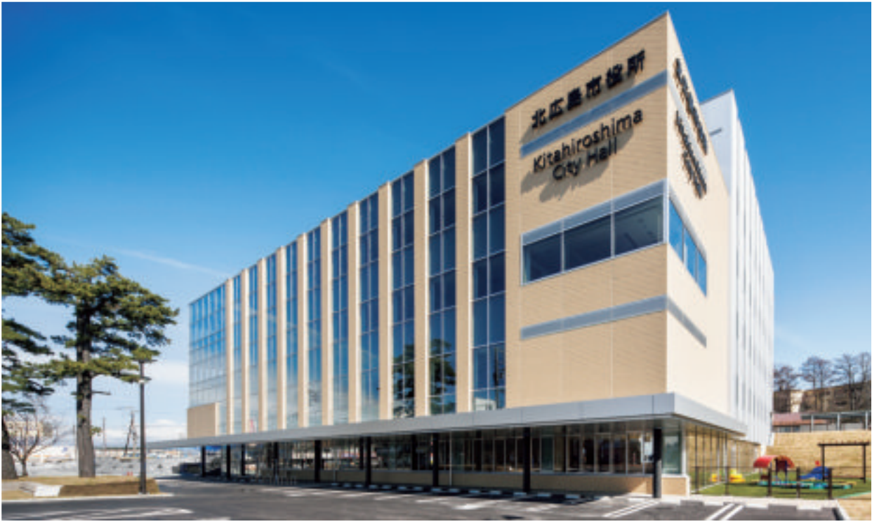
北西側外観（右は地域子育て支援センターに連続するプレイロット）
