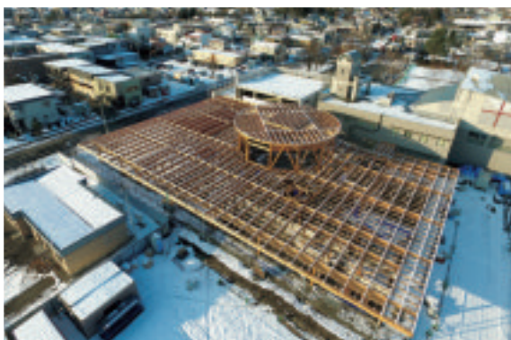
建設時の様子
