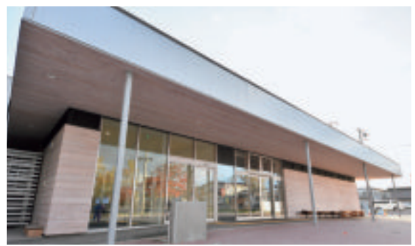
北側正面外観 ※
