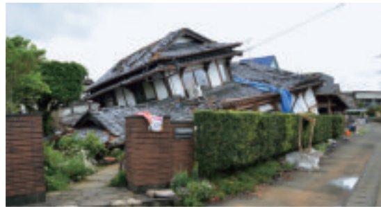
熊本地震（H28）での建物被害
