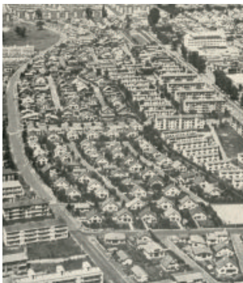
写真2 三角屋根CB造住宅団地 出典：北海道の建築1963-1974 (日本建築学会北海道支部、昭和50年)
