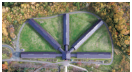
博物館網走監獄の舎房及び中央見張所（網走市）。五翼放射状房と呼ばれる。1912（明治45）年に建築、1985年に移築。2016年に庁舎などと共に国の重要文化財に指定された。※5
