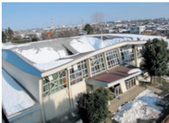
写真1 2014年2月の大雪による被害例<sup>1)</sup>
