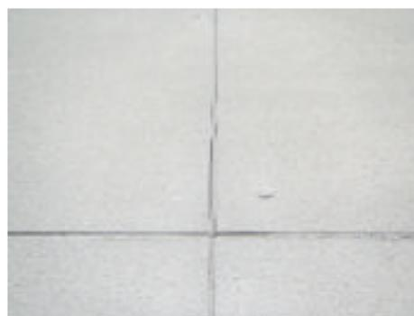
写真6 パネル間目地シーリングの破断（西面）
