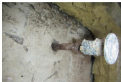
写真8 主アンカーの腐食状況
