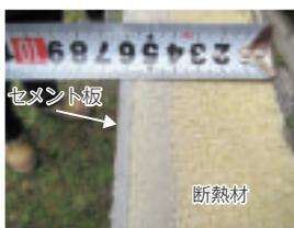
写真4 パネルの断面状況
