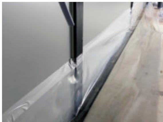
写真2 外壁の気流止め措置
