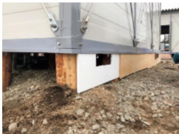
写真4 簡易基礎断熱工法
