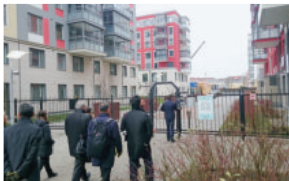
分譲マンションの建設現場（サンクトペテルブルク）
