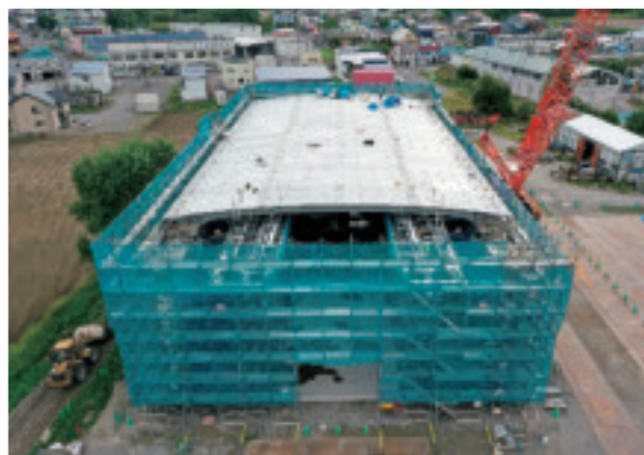
写真3 建設中の新工場棟全景
