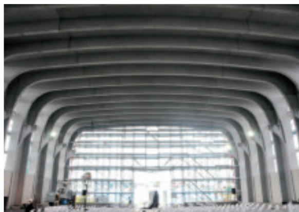
写真2 建設中の新工場棟内部
