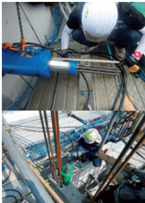
写真1 プレストレス導入時の様子
