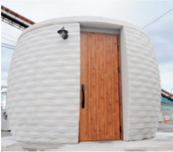
写真7 インド向けトイレ（プロトタイプ）
