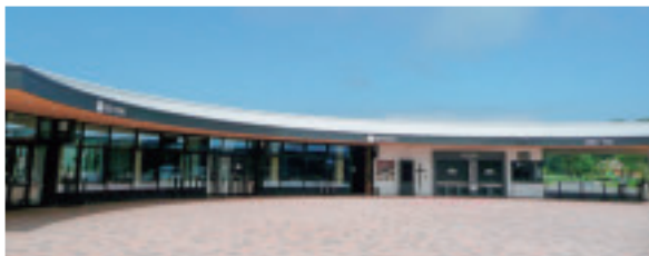
エントランス棟
