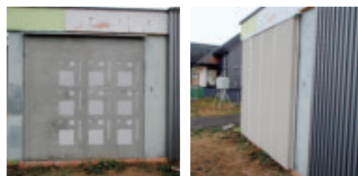
写真1 外断熱外壁試験体の作製状況
