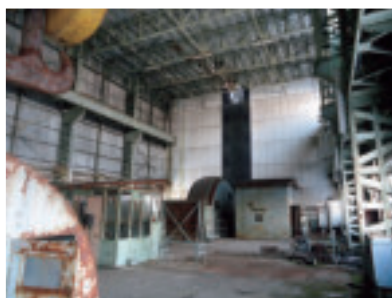
写真4 赤平炭鉱：捲揚げ室
