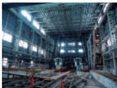
写真3 赤平炭鉱：操車場
