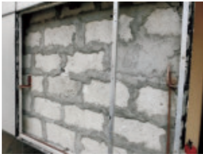
写真4 30mm 以上の目地モルタル（写真提供：石山祐二氏）
