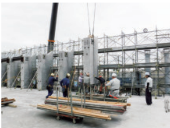
PCa 柱の組み立て状況
