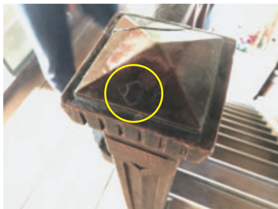
写真4 和館階段の親柱柱頭に見つけた彫り込み
