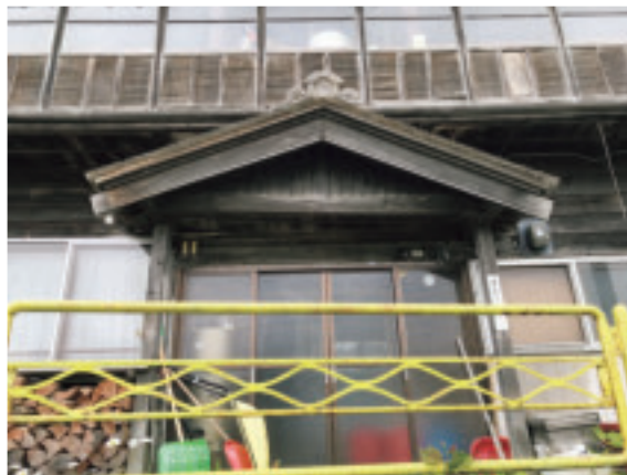
写真3 玄関屋根には桼葺きが残る
