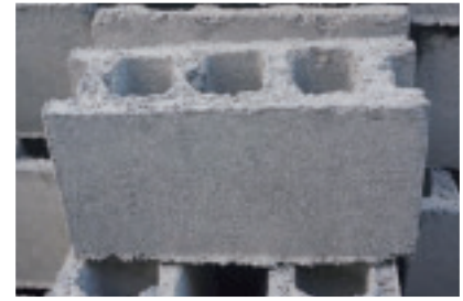
写真3 大手製造会社の低い寸法精度の CHB（写真提供：米澤稔氏）
