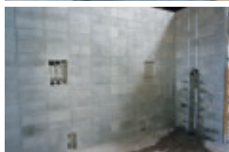
写真8 階高充填試験
