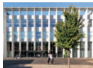
日射遮蔽の機能を持たせた列柱
