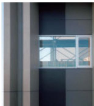
外壁ユニットのモックアップ
