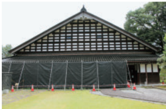
富山市民俗民芸村にあるアズマ建ちの陶芸館 (左側での山留め工事の養生中)
