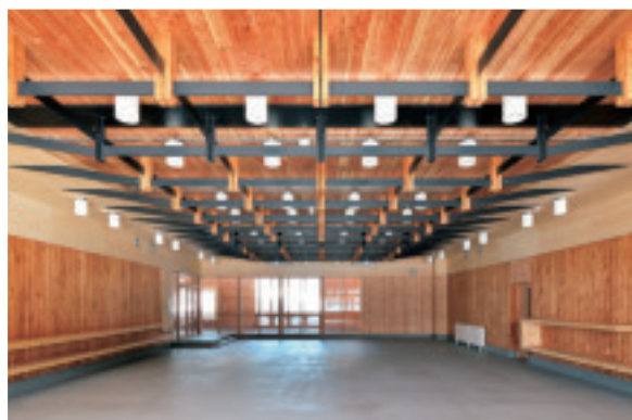
CLT 張弦床架構
