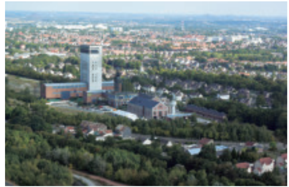
写真19 ズリ山から眺める旧炭鉱施設と炭鉱住宅街
