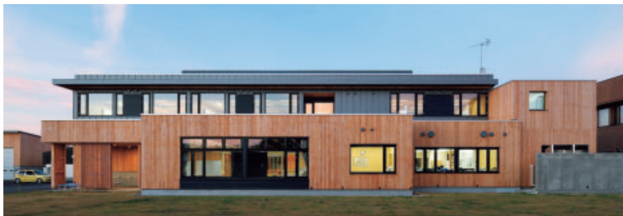
西側外観。板金が夕日を柔らかく反射する
