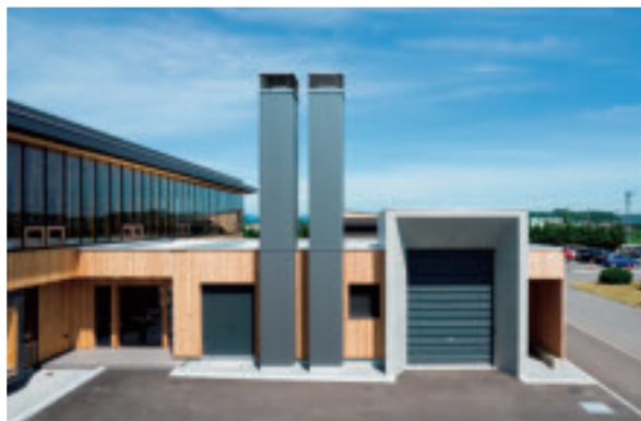
エネルギーパビリオン（機械室）外観
