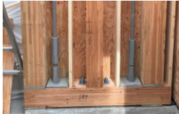
拡張型 SSW14耐力壁施工状況
