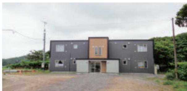
木造2階建ての課題である「音」の対策として、上下階の構造を分離し遮音を図るとともに、住戸と階段室間の壁も二重壁とするなど設計上の工夫がなされている。
