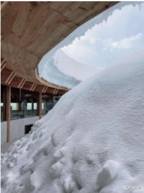
勾配屋根でありながら無落雪屋根を実現した逆円錐状の屋根形状。中庭の雪は降り積もったもの
