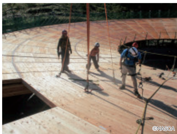
屋根CLTの施工
