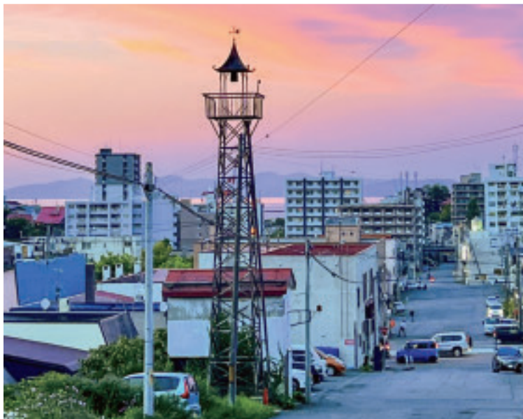
改修工事前日（2023.9.17）撮影
