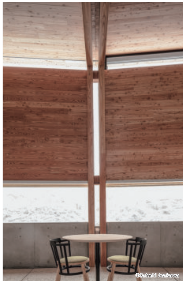
軽快感のある合わせ柱と固定端を構成する RC 壁
