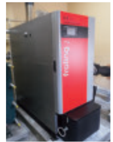
写真6 木質バイオマスボイラー棟の外観（上）と導入されたチップボイラー（右）
