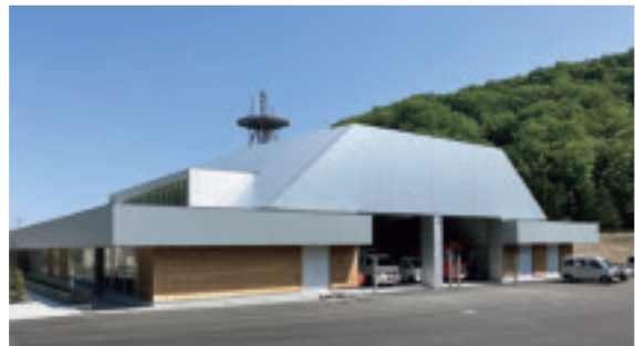
奥尻町総合庁舎（消防側）の外観
