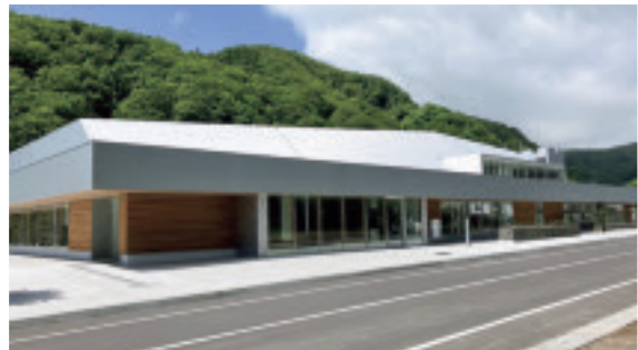
奥尻町総合庁舎（道路側）の外観
