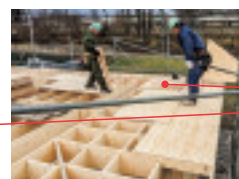
屋根合板の施工状況
