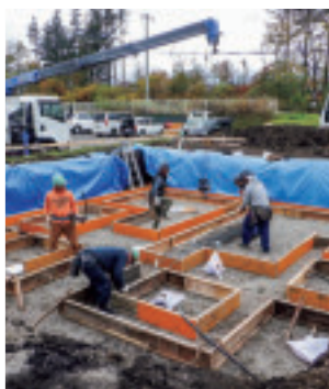
型枠工事と配筋工事
