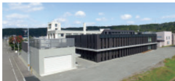
南側壁面に太陽光パネルを設置し、基幹設備（キュービクル・非常用発電機・室外機）を屋上に設置
