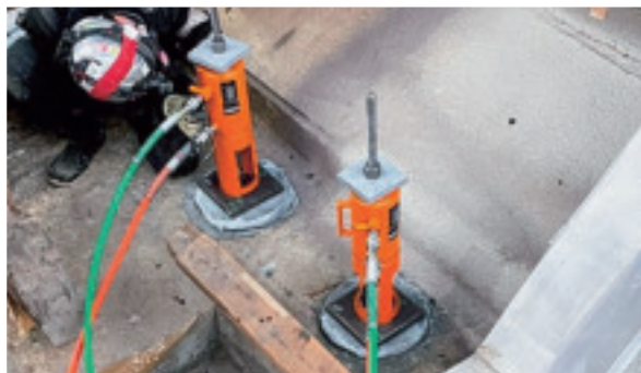
PC 棒鋼への緊張力の導入
