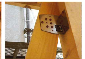
(スジカキ、耐震金物施工例)
