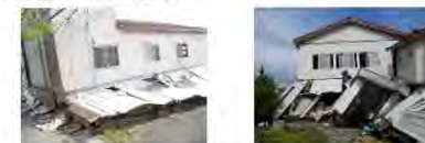
写真 4-7 店舗併用住宅の倒壊被害
