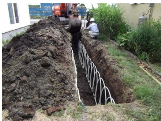
水平採熱式地中熱ヒートポンプ
