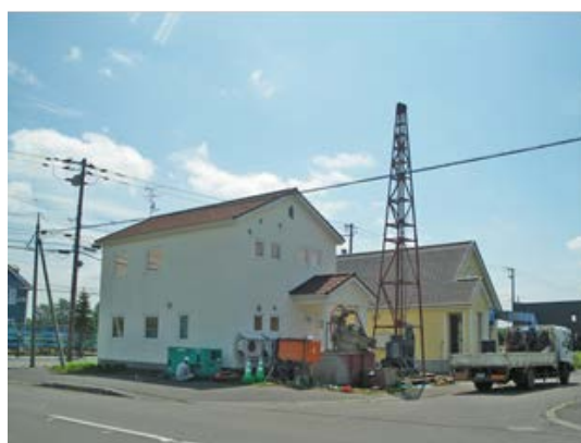
ボアホール式地中熱ヒートポンプの施工
