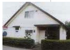
ブロック造住宅
