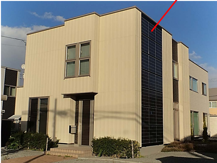
壁面太陽光発電の設置事例 (旭川市内)
